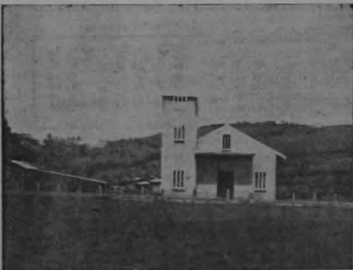
IGLESIA DE SANTIAGO DE SAN RAMON, construida por el Ministerio de Obras Públicas, con un aporte de ₡ 113.750.08. Los vecinos colaboraron con algunos materiales. Esta obra viene a llenar necesidades espirituales de los vecinos de Santiago que agradecen a la actual Administración un edificio de tal naturaleza.
